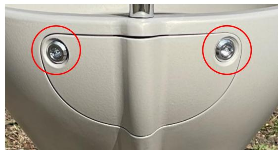
Am linken Ventil Durchflussmenge mit Gabelschlüssel (5mm) einstellen.
